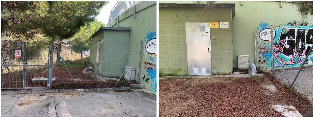
Figura 5. Exterior del dipòsit Puig de les Forques
