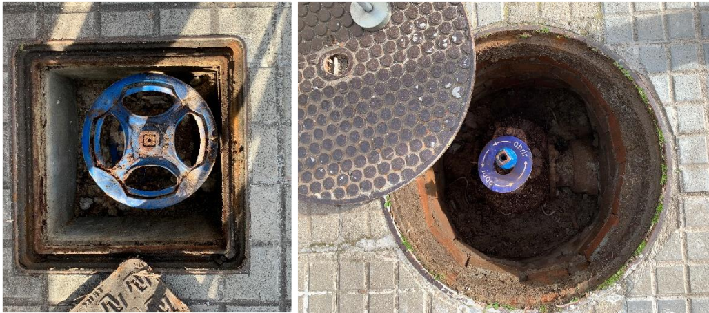
Figura 20. Vàlvules de seccionament
