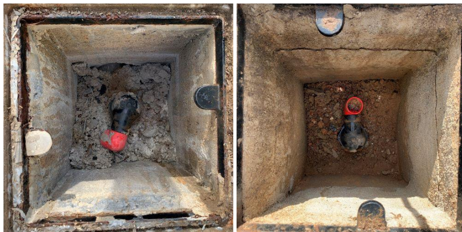
Figura 21. Ventoses al municipi de Granollers
