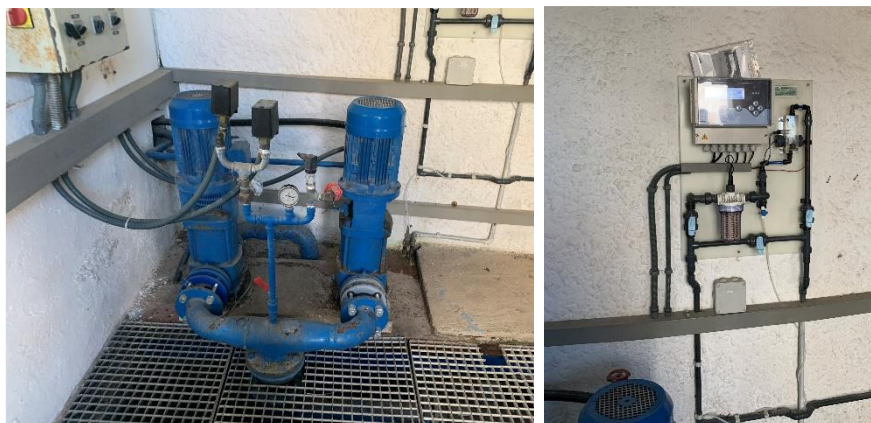
Figura 9. Grup de pressió i analitzador fix multiparamètric del dipòsit Coll de la Manya
