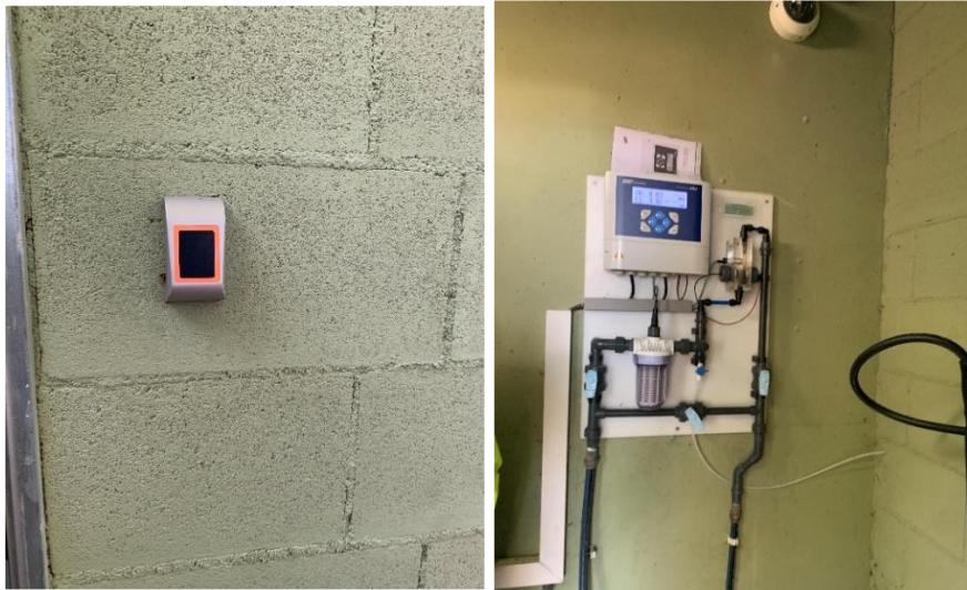
Figura 6. Control d'accés i analitzador fix. Dipòsit Puig de les Forques
