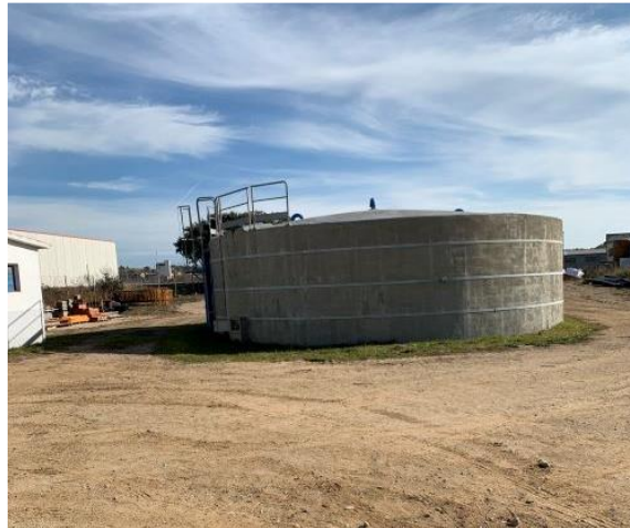
Figura 13. Exterior del dipòsit de Can Serra
