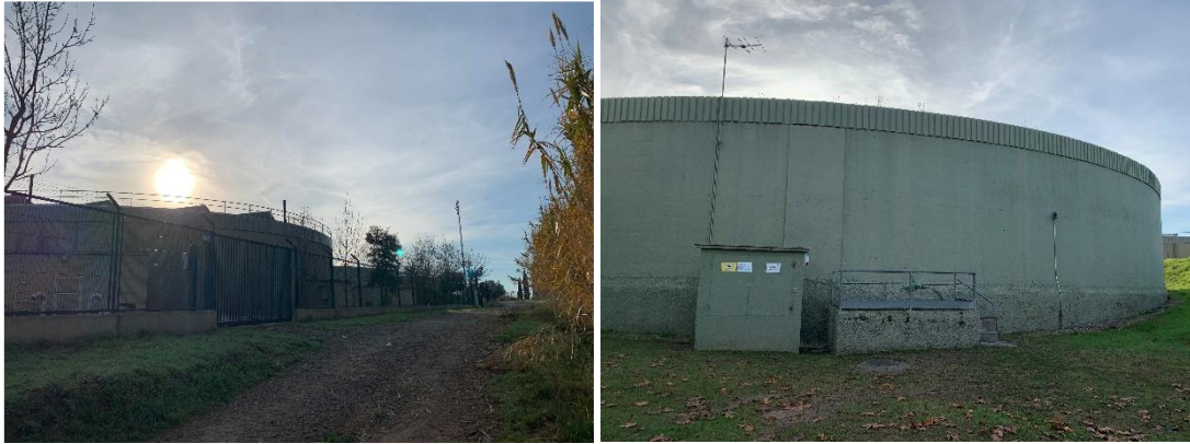
Figura 3. Vallat i exterior del dipòsit municipal
