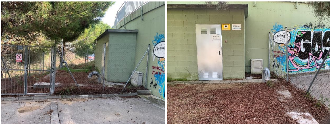
Figura 15. Exterior del dipòsit Puig de les Forques
