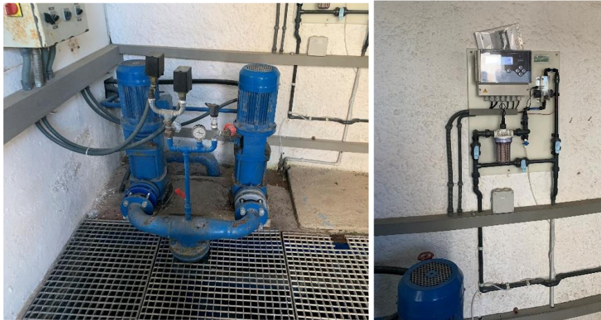
Figura 18. Grup de pressió i analitzador fix multiparamètric del dipòsit Coll de la Manyà
