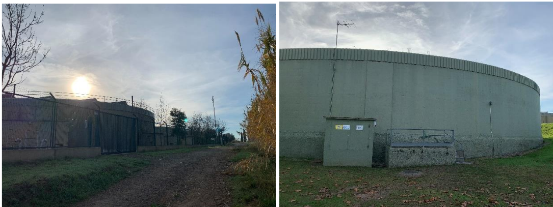
Figura 14. Vallat i exterior del dipòsit municipal
