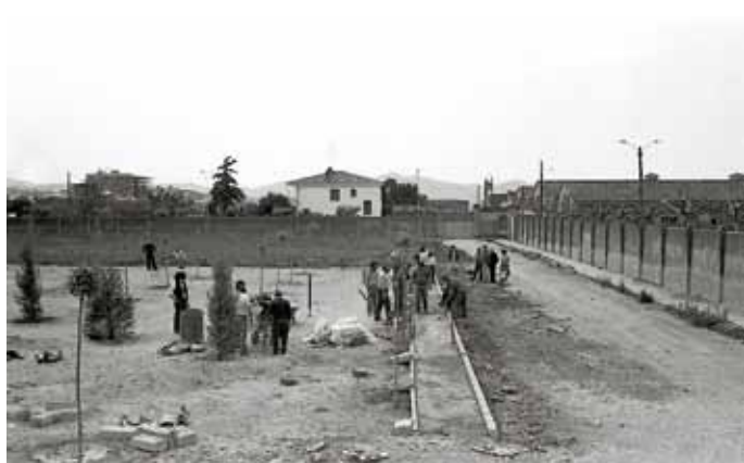
Els veïns treballant en la construcció de la plaça Sant Miquel, 1979. Autor i fons Jaume Oller / AMGr
