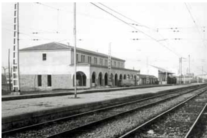
Edifici de la nova estació l'any de la seva inauguració, 1964. Autor desconegut / Fons Ajuntament de Granollers / AMGr
