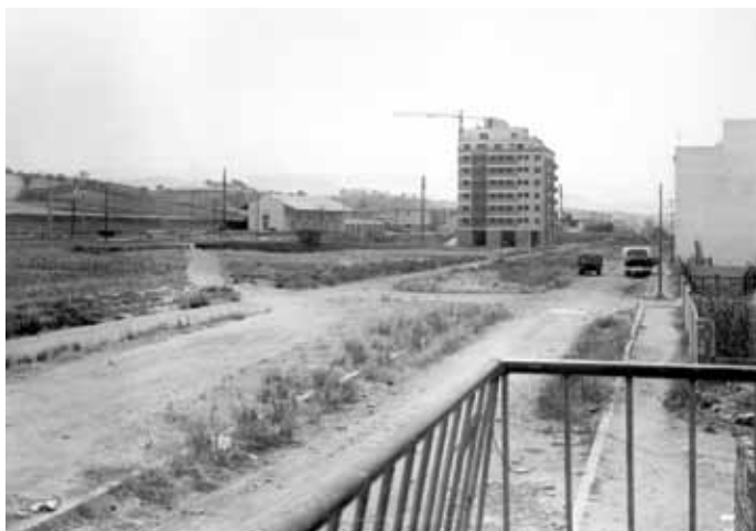
L'avinguda de Sant Esteve amb els pisos Roura des d'un balcó a la cantonada del carrer Bisbe Grivé, 1962. Francesc Comas / Fons Ajuntament de Granollers / AMGr
