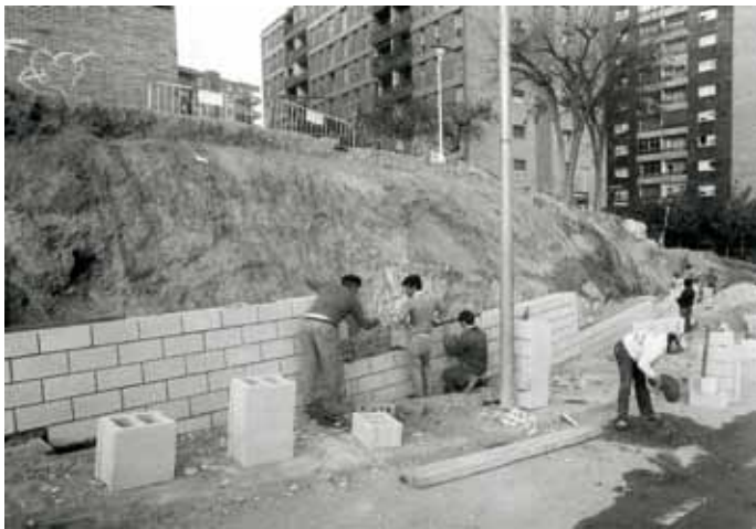
Obres d'urbanització al barri de Can Gili, 1983. Autor desconegut / Fons Ajuntament / AMGr
